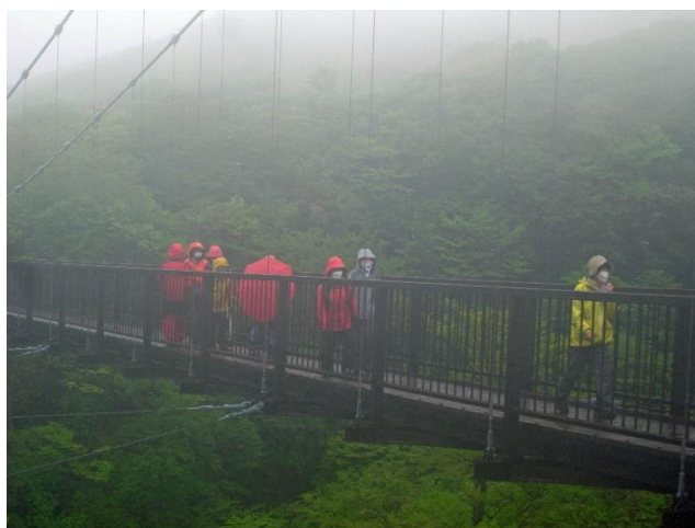
つつじ吊橋 L：130m H：38m
