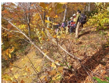
天保古道の崩壊を高巻く
