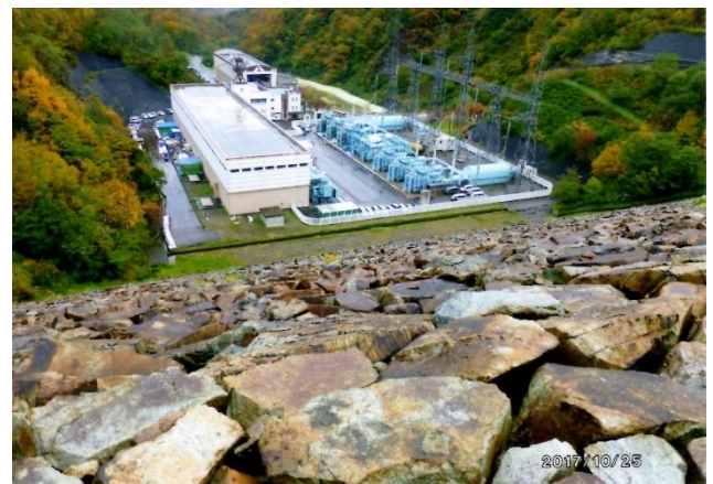
奥清津第二発電所
