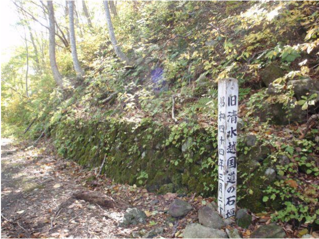
旧清水越国道の石垣
