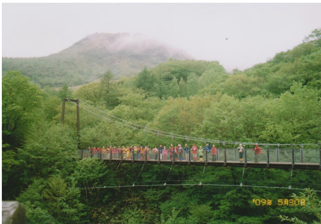
八幡つつじ園への途中の自然研究路の弁天吊橋
